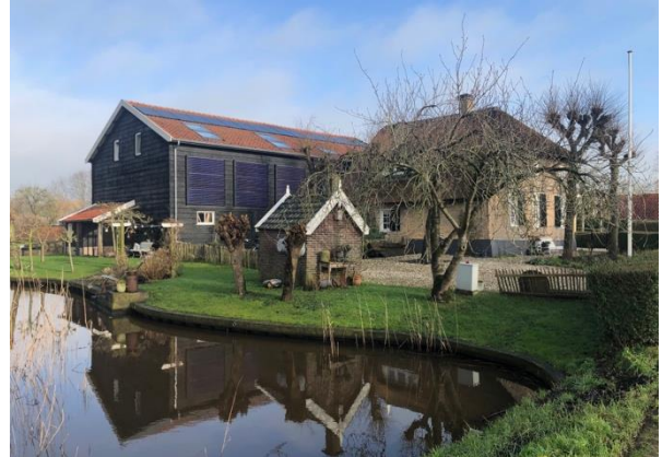
Rijksmonument Abbekesdoel 43, Bleskensgraaf. Zonnepanelen op de schuur en zonneboilerpanelen tegen gevel (is dit passend?)
