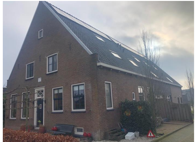
Dorpsstraat 8/8A Bleskensgraaf; gerenoveerde boerderij met twee woningen; op het dak aan weerszijden een rij zonnepanelen.
